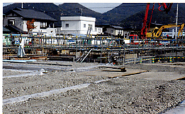
建設進む鈴川・大野目特養施設
